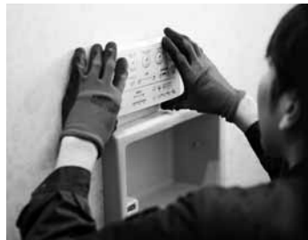
水まわりのプロが丁寧に施工
